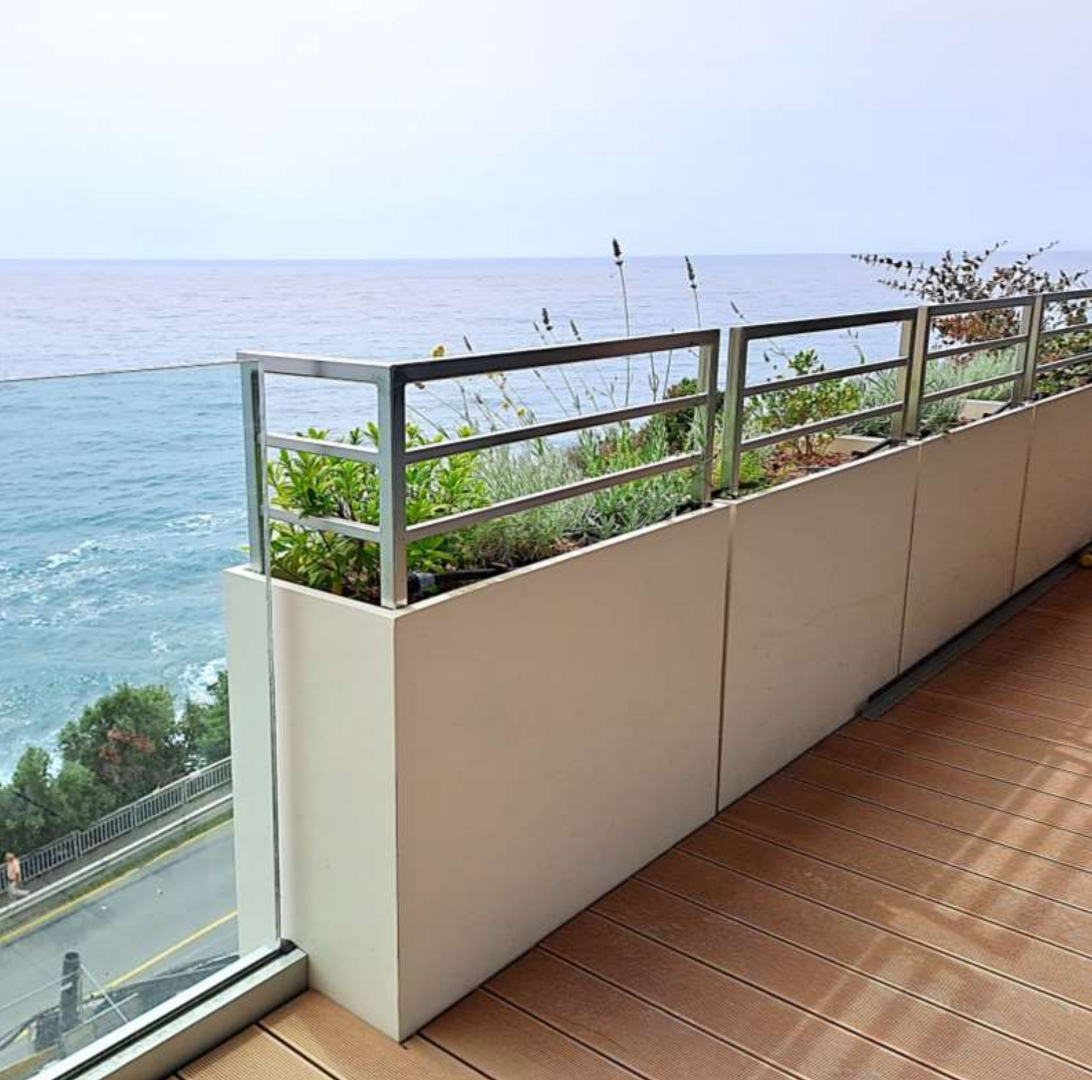
Fioriera parapetto per balconata di edificio residenziale. Costruzione su misura in Recomplax Basic e finitura in resina bicomponente / Parapet planter for balcony of residential building. Customized construction in Recomplax Basic and two-component resin finish
