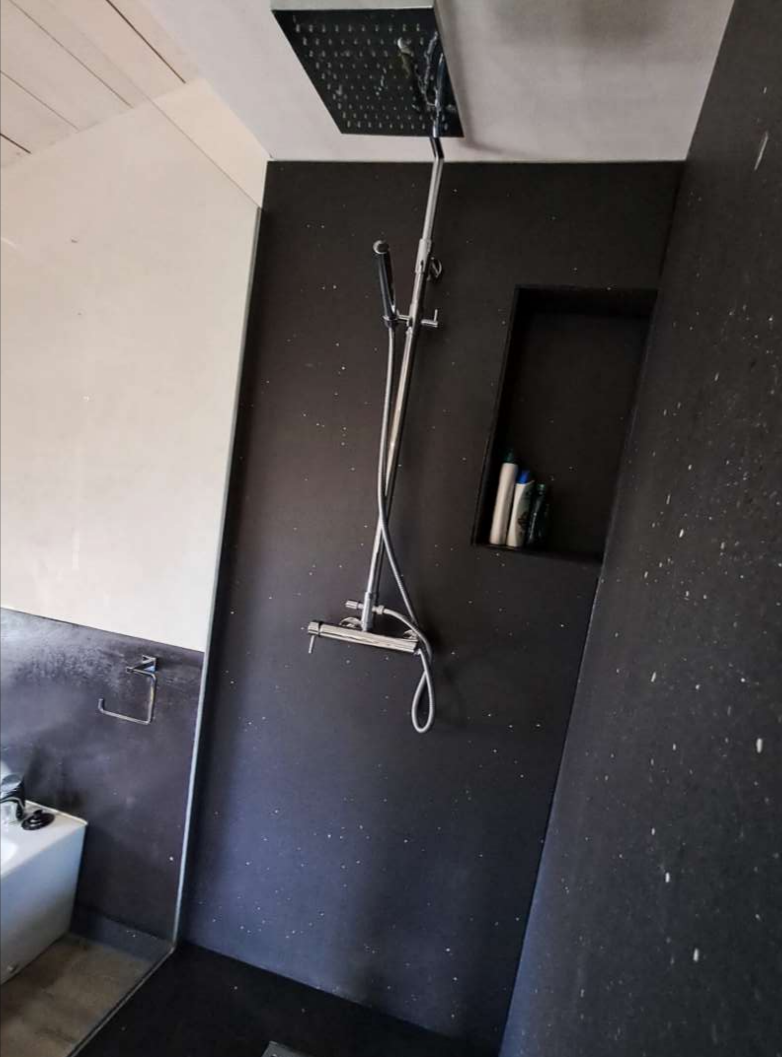
Recomplax HDRF per box doccia su misura di edificio residenziale. Pannellature laterali ad incastro nel piatto doccia e incollaggio a tenuta d'acqua su tutti gli angoli interni / Recomplax HDRF for custom-made shower enclosures in residential building. Interlocking side panels in the shower tray and watertight gluing on all internal corners.
