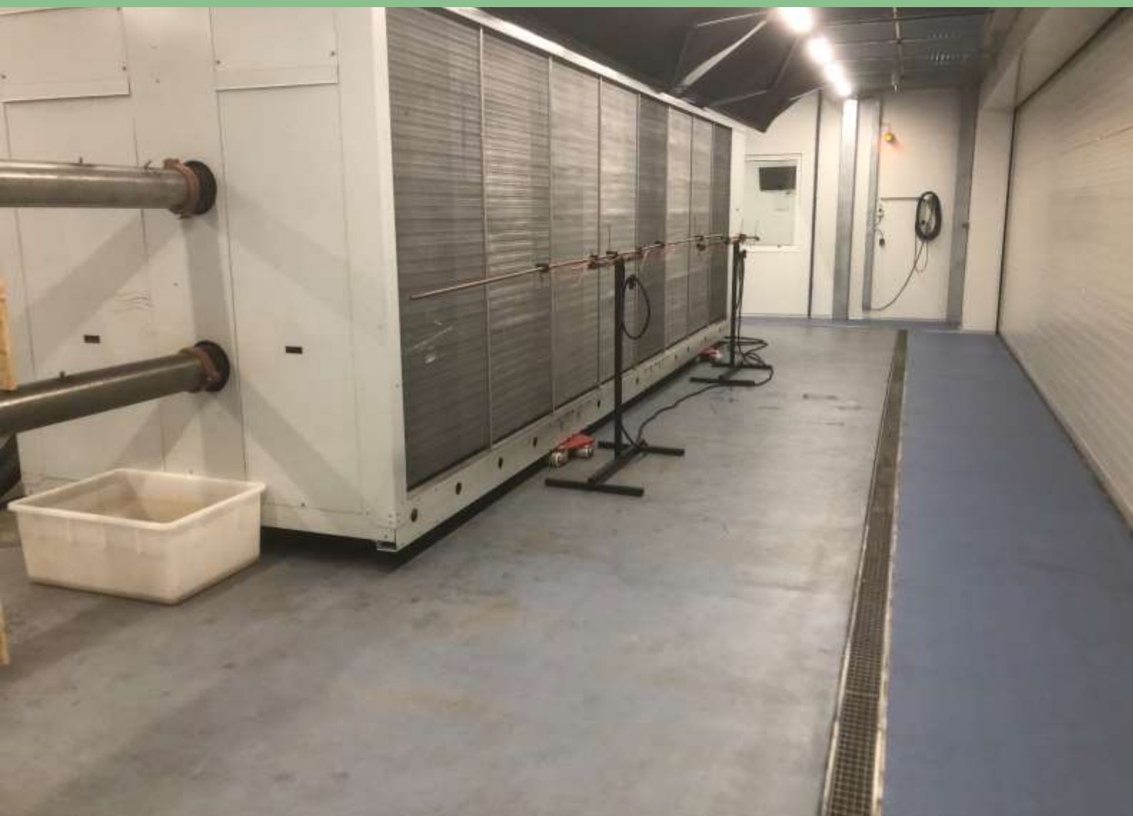
Recomplax Basic D1100 per pavimentazione locale tecnico rifinita in resina epossidica / Recomplax Basic D1100 for technical room flooring finished in epoxy resin
