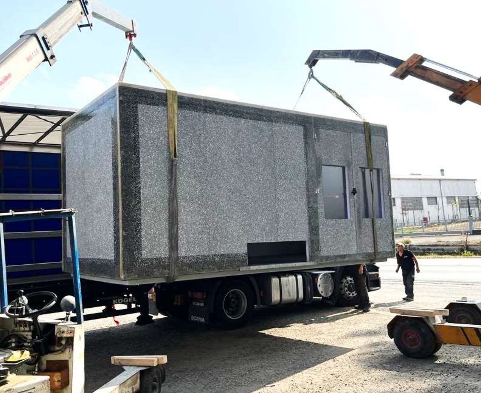
In questo shelter da 20 ft realizzato nell'ambito del progetto MAELSTROM (Horizon 2020) sono stati prodotti pannelli sandwich con rinforzi e lastre Recomplax D'ecò abbinate a espansi rigidi EPS / In this 20 ft shelter created as part of the MAELSTROM project (Horizon 2020), sandwich panels were produced with Recomplax D'ecò reinforcements and sheets combined with EPS rigid foams
